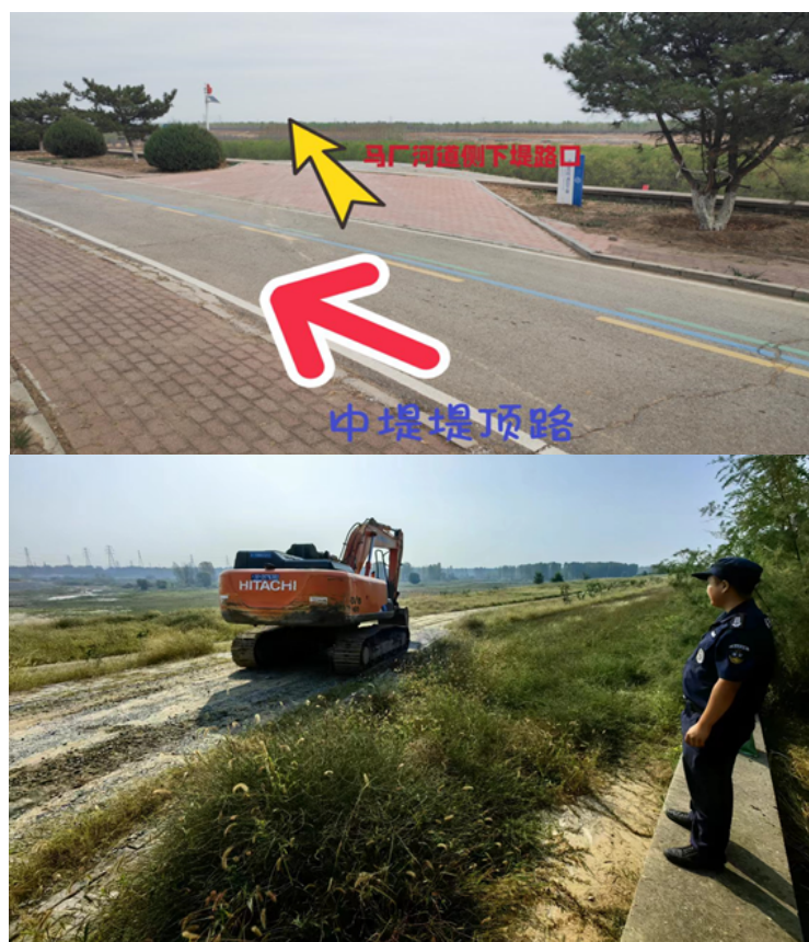
马厂河道侧堤坡施工
