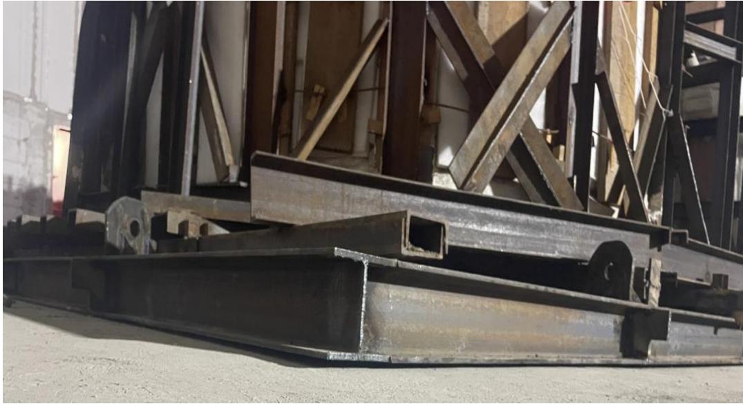
外部钢结构保护支护现状
