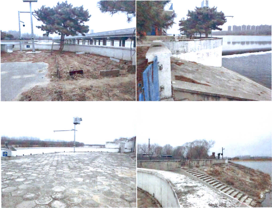
橡胶坝管理站防浪墙
