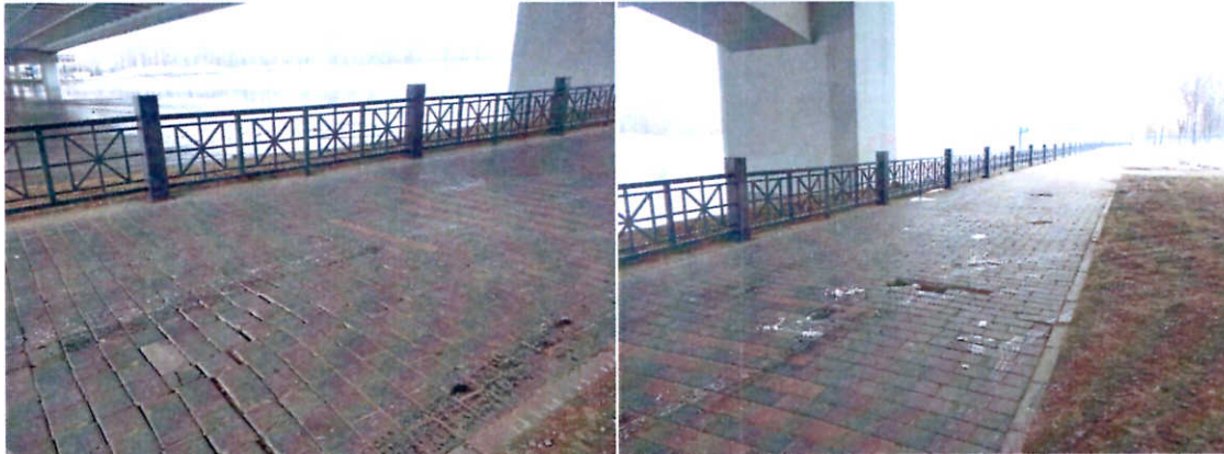
复兴大桥下巡河路
