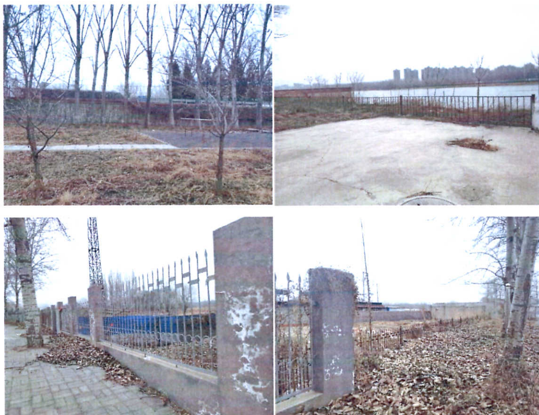
橡胶坝管理站护栏
