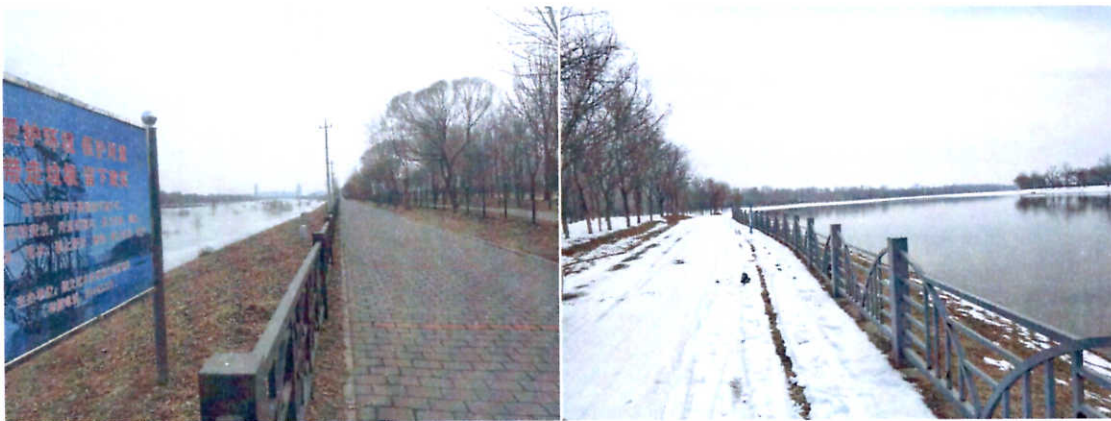
潮白河向阳闸至城北减河口段左右岸巡河路
